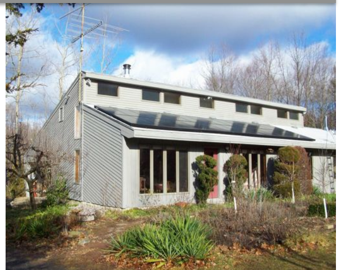
5.9 kW Solar Array
